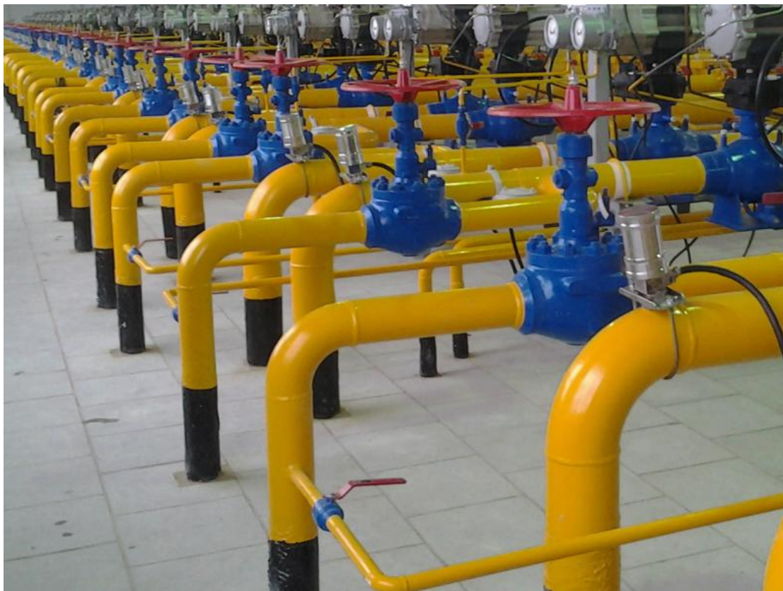
Рисунок 8. Оснащение входа технологических ниток датчиками ДСП-АКЭ-2 на ГСП ПХГ
